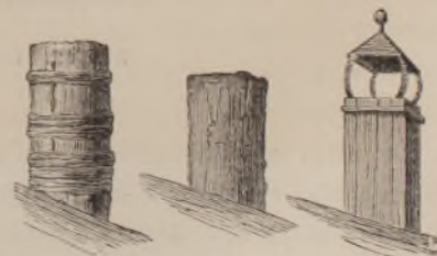
Bild 48. Rökledare (skorstenar af trä) å finska pörtten.
