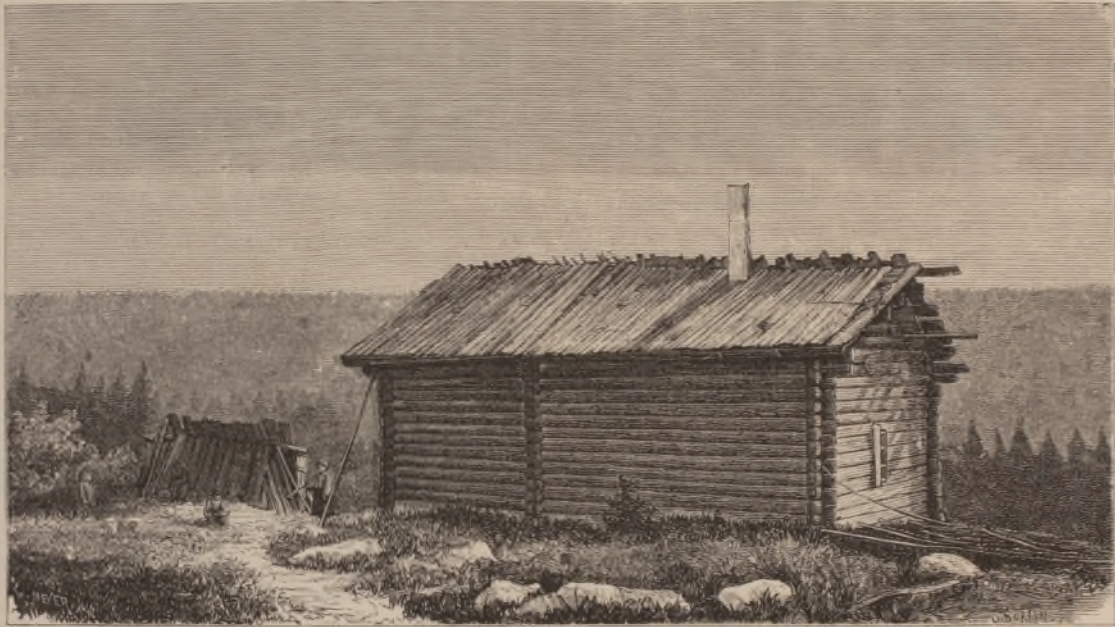
Bild 98. Pörte (rökstuga) vid Elgsjön. Till vänster därom synes ett litet, af åtskilliga i spetsig vinkel mot hvarandra ställda spjalar bygd skjul, hvilket tjänar såsom kök. Efter fotografi.
