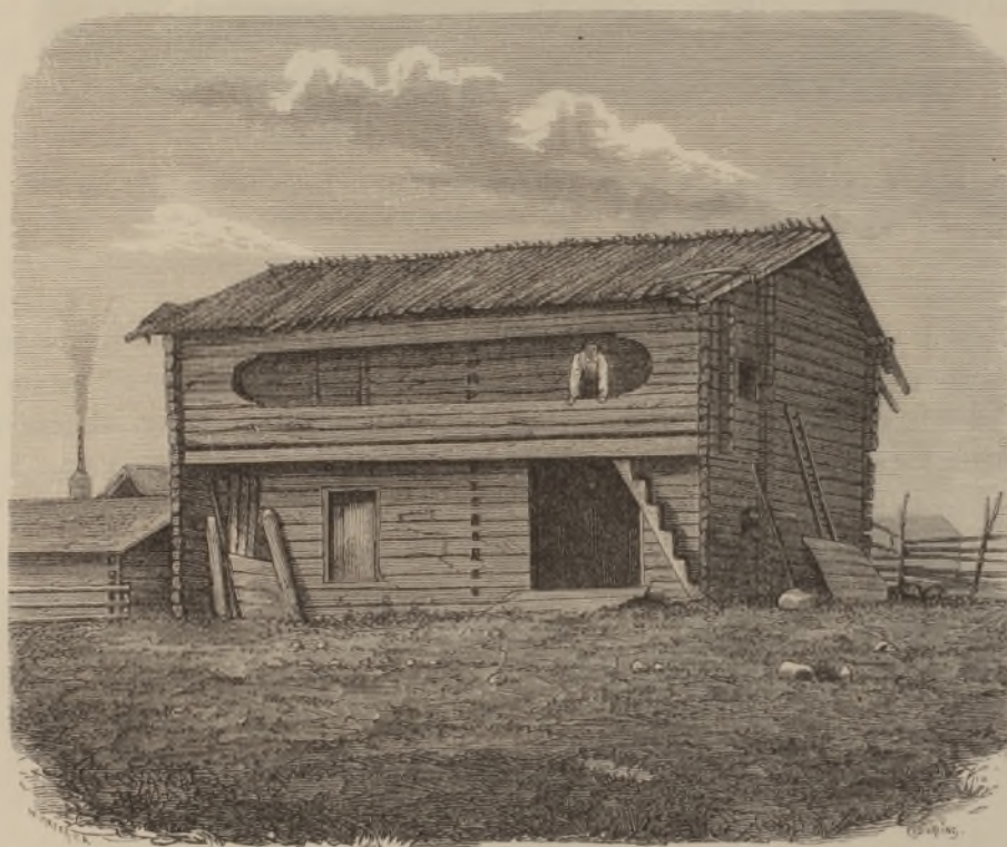
Bild 73. Bod från Yläjärvi gård, ej långt från Tammerfors. Efter fotografi. Till den öfre våningens loft, där en man synes stå framåtlutad, leder en högst primitiv trappa, bestående af en furustock, i hvilken stora afsatser äro inbuggna.
