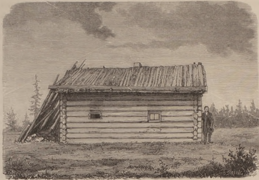
Bild 93. Pörte vid Klyperud. Till vänster synes utanför den här belägna dörrringången ett slags skjul af klufna granspjälkar och försedt med en af några sammanlagda lösa stenar bildad eldstad. Efter fotografi.
